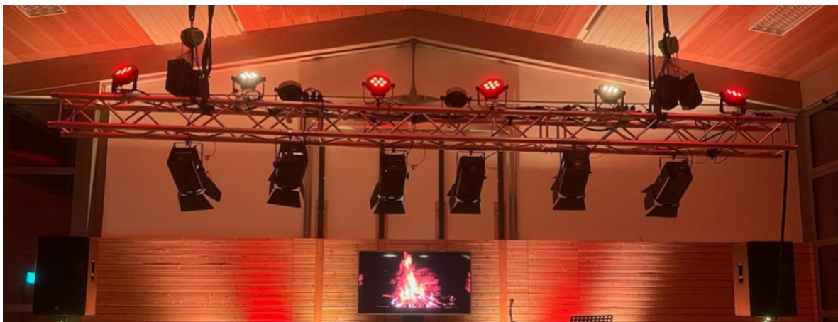
Lichttraverse mit konventionellen Stufenlinsen.
